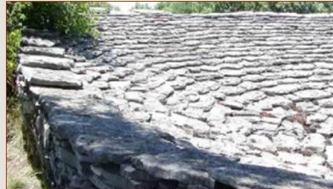
Toit citerne or roof cistern (source : PNRGC)
